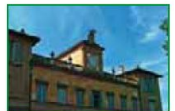
La facciata della Villa Mondeggi
